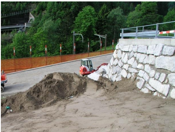
Moderne, mit Maschinen errichtete Zyklopenmauern
