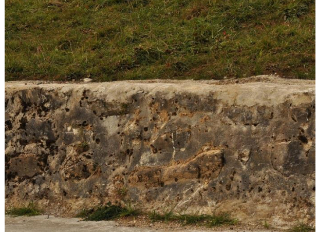
Betonierte, verfugte Stützmauer mit Natursteinen
