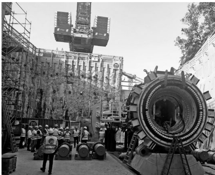
Die Tunnelbohrmaschine im Aufbau
